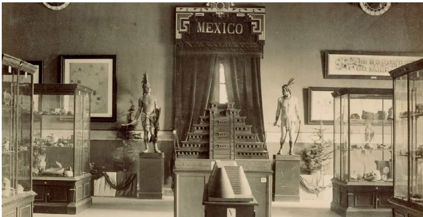
Una vista de la Sala III, tomada desde la Sala II. (Foto: BNE)
